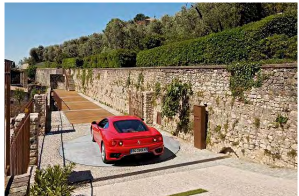
Una volta posizionata l'auto sulla piattaforma rotante l'utente scende e si reca al quadro di comando.
